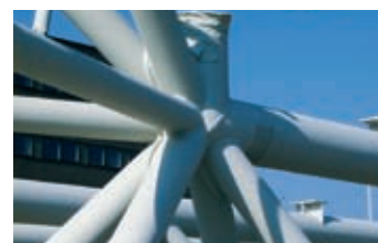
Komplexní styčnickové spoje
